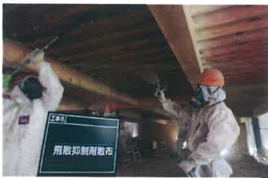
アスベスト除去作業の様子
